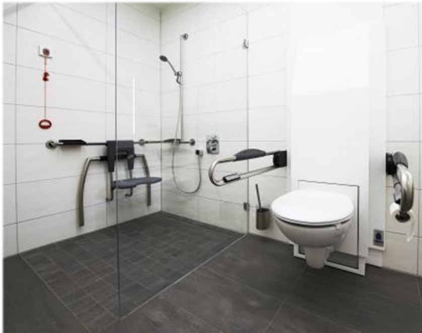
Rollstuhlgerichtetes Badezimmer mit Notruftaster, höhenverstellbarem WC und Sitzmöglichkeit in der Dusche
